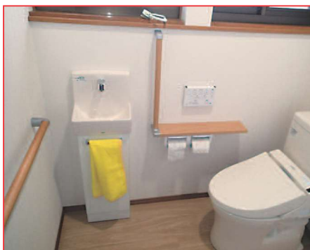
トイレの全面改修もできます。
