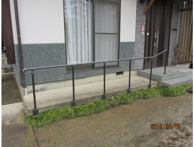
壁受けスタンドを使用した施工方法。
