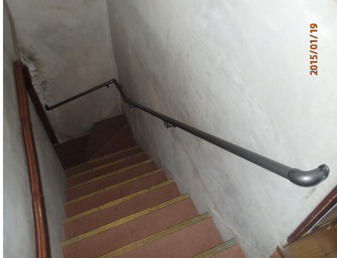
コンクリート壁への手すりの取付け。
