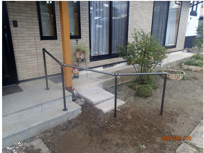
成形ブロックは施工後埋設します。
