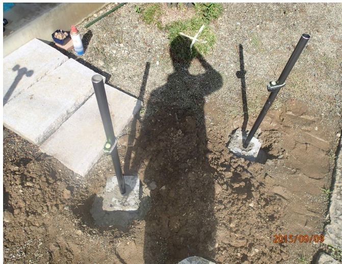
成形ブロックを埋め、手すりを取り付ける施工方法。
