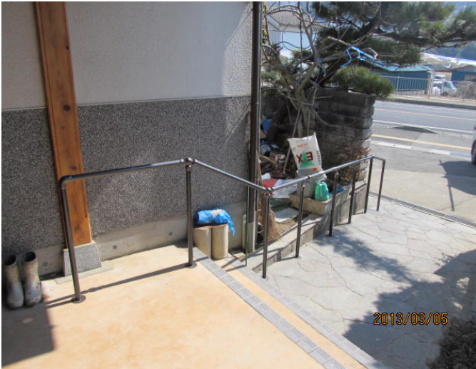
コア抜きでの支柱の立ち上げ施工。
